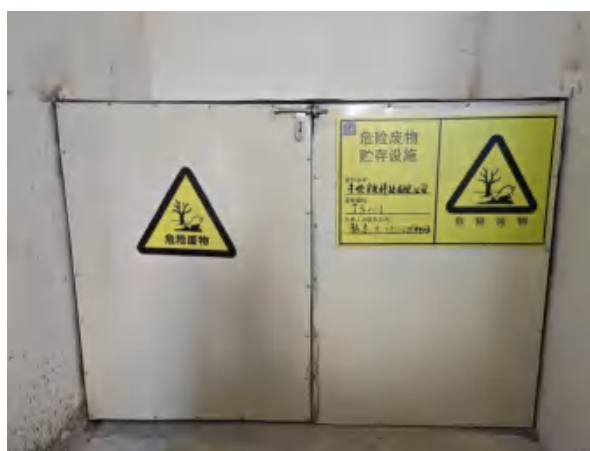
图6 危险废物贮存设施
