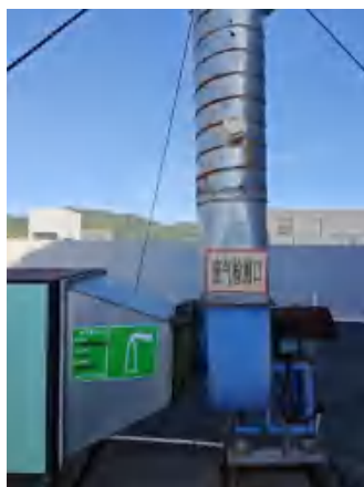
图7 废气处理设施标识及采样平台
