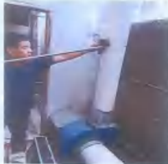
有机废气排放口
