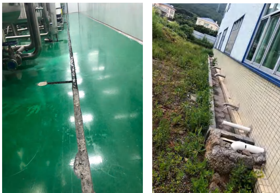
图 3-1 废水治理措施现状图
