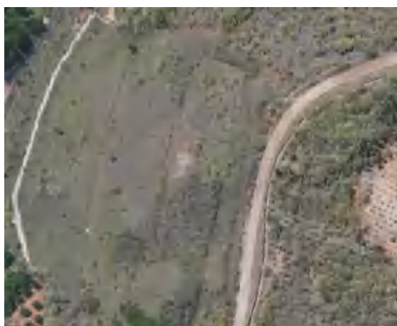
矿渣堆削坡整治（航拍1）
