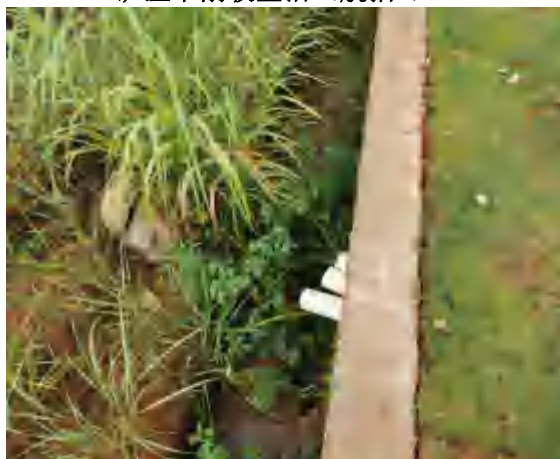
排土场护脚挡土墙
