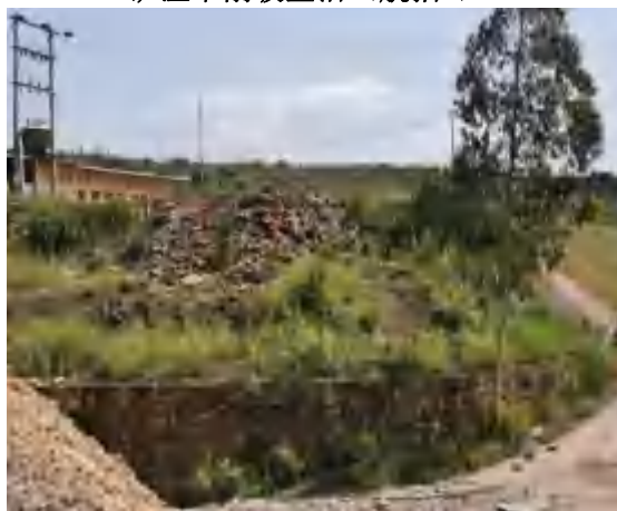
排土场护脚挡土墙（1）
