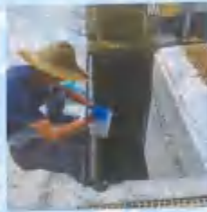
W2 废水排放口
